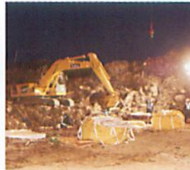
2011.12 夜間作業の様子 (宮城県石巻市)
